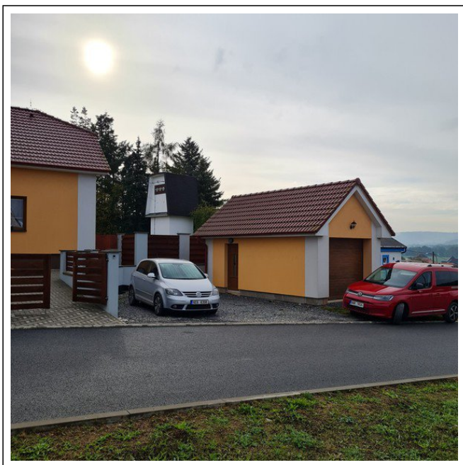
Severní pohled - garáž
