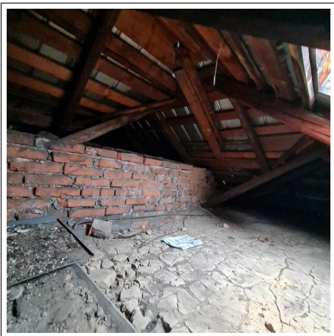
Nosná konstrukce střechy
