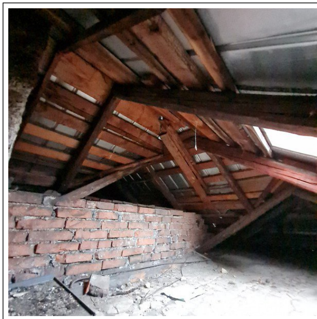
Nosná konstrukce střechy
